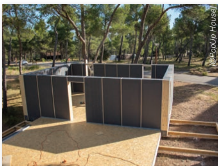
Lorsque le terrain le permet, les fondations sont réduites à leur plus simple expression.
