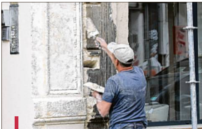
La maçonnerie est un des métiers où il y a le plus de besoins dans le BTP et la construction. /PHOTO DAVID ROSSI
