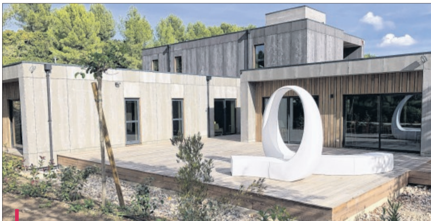
Un totem blanc marque l'entrée de ce pôle entrepreneurial. Un lieu mixant, en deux ailes, des usages classiques du bureau et des espaces libres pour travailler sous toutes ses formes seul, à plusieurs pour une heure ou des mois. /PHOTOS P.S & DR
